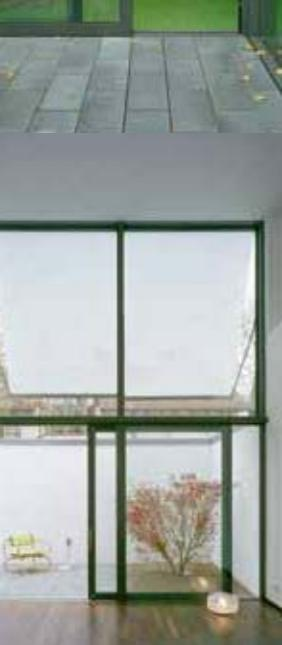
**3-rail** integreert een extra rail wat de mogelijkheid biedt om een derde openende vleugel toe te voegen. Deze oplossing laat gebruikers toe om tot drie schuivende delen te gebruiken waardoor 2/3 van de schuifdeur geopend kan worden.
